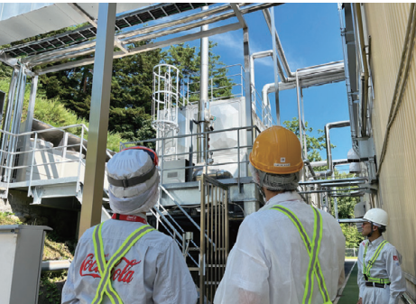
AWS監査実施の様子（白州工場）
