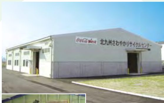
廃棄自動販売機リサイクル施設
