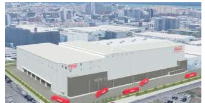
明石メガDC新倉庫
